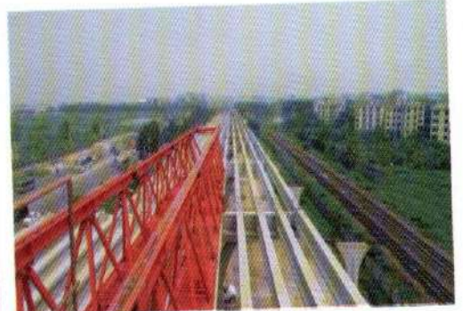
আই গার্ডার ইরেকশন
