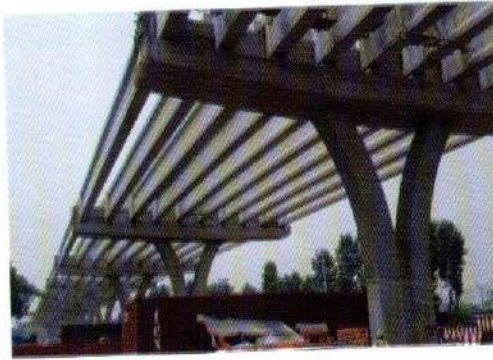
আই গার্ডার ইরেকশন
