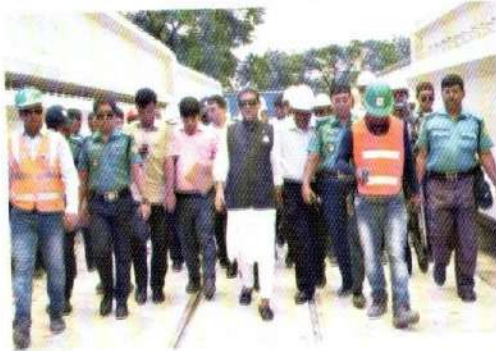
মাননীয় সড়ক পরিবহন ও সেতু মন্ত্রীর চলমান কাজ পরিদর্শন
